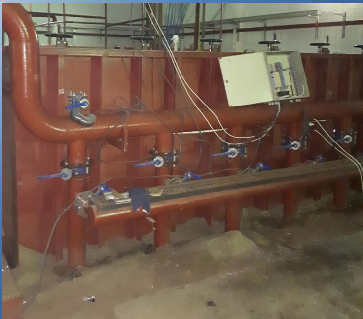
Корпус низконапорного оксигенатора Расход воды 1000 м 3 /час, насыщение 120 – 135%
